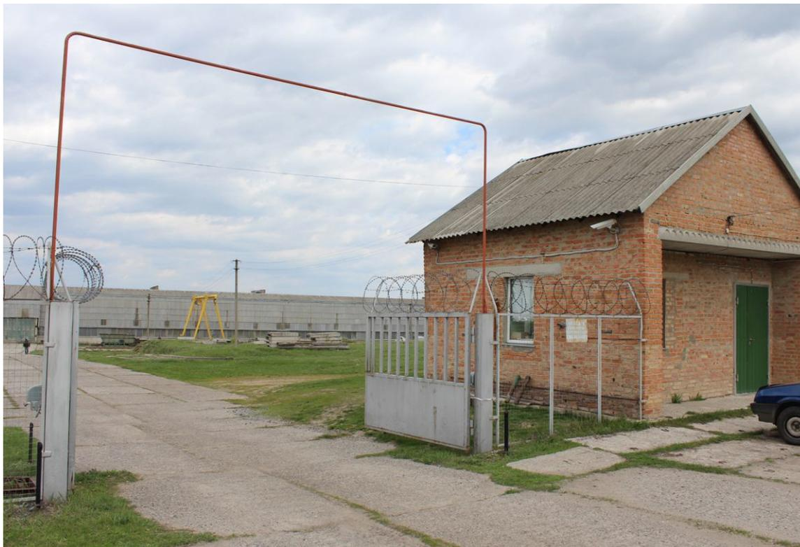
Одноэтажное здание площадью 36 кв.м (6,0х6,0 м.), с продольными и поперечными стенами толщиной 510 мм. Перекрытие выполнено из железобетонных пустотных плит. Крыша – чердачного типа, двухскатная, кровля – из волнистых асбестоцементных листов по деревянной обрешетке. Перемычки – железобетонные. Высота помещений – 2,5м.
