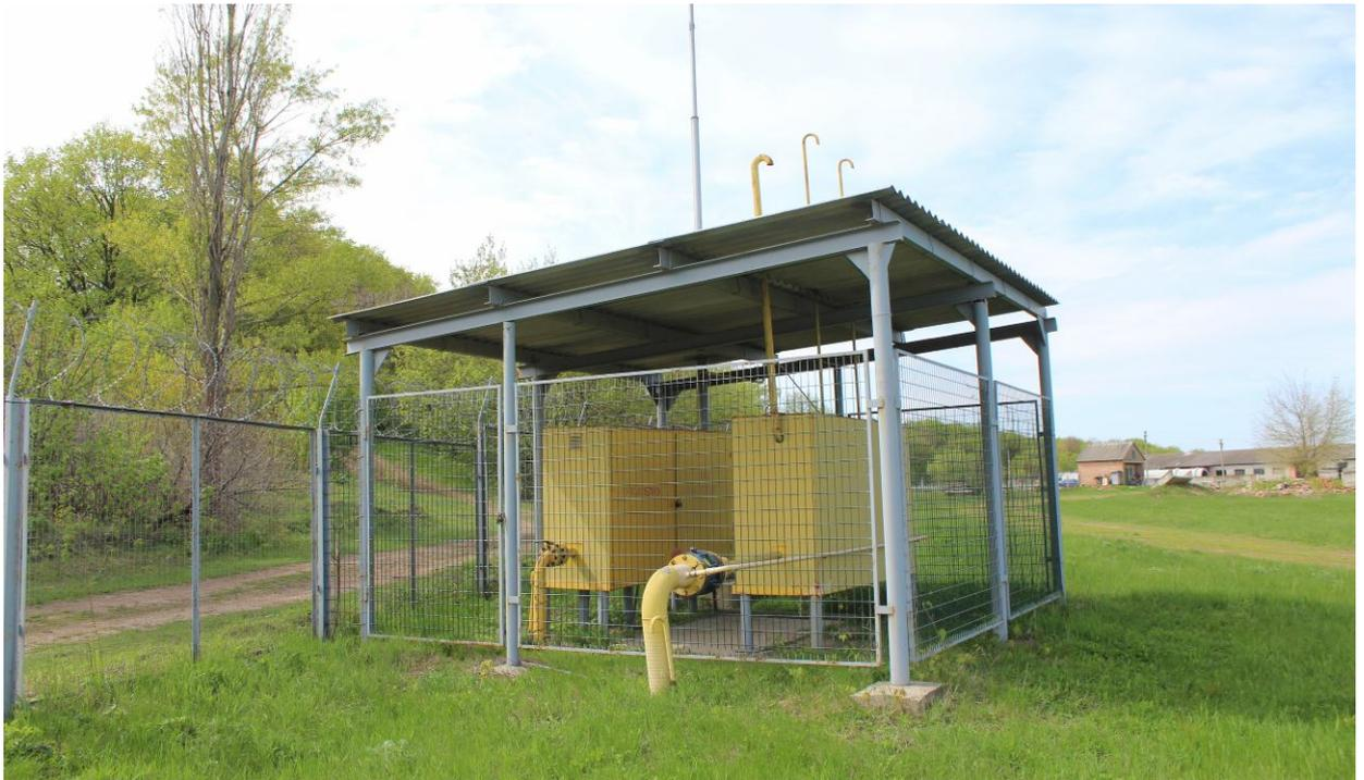
После регуляторной установки газопровод проложен подземно до административного здания из полиэтиленовых труб ПЕ 80, затем по наружной стене здания надземно – к печному отделению, из стальных труб  $\Phi 159 \times 3,5$ .
