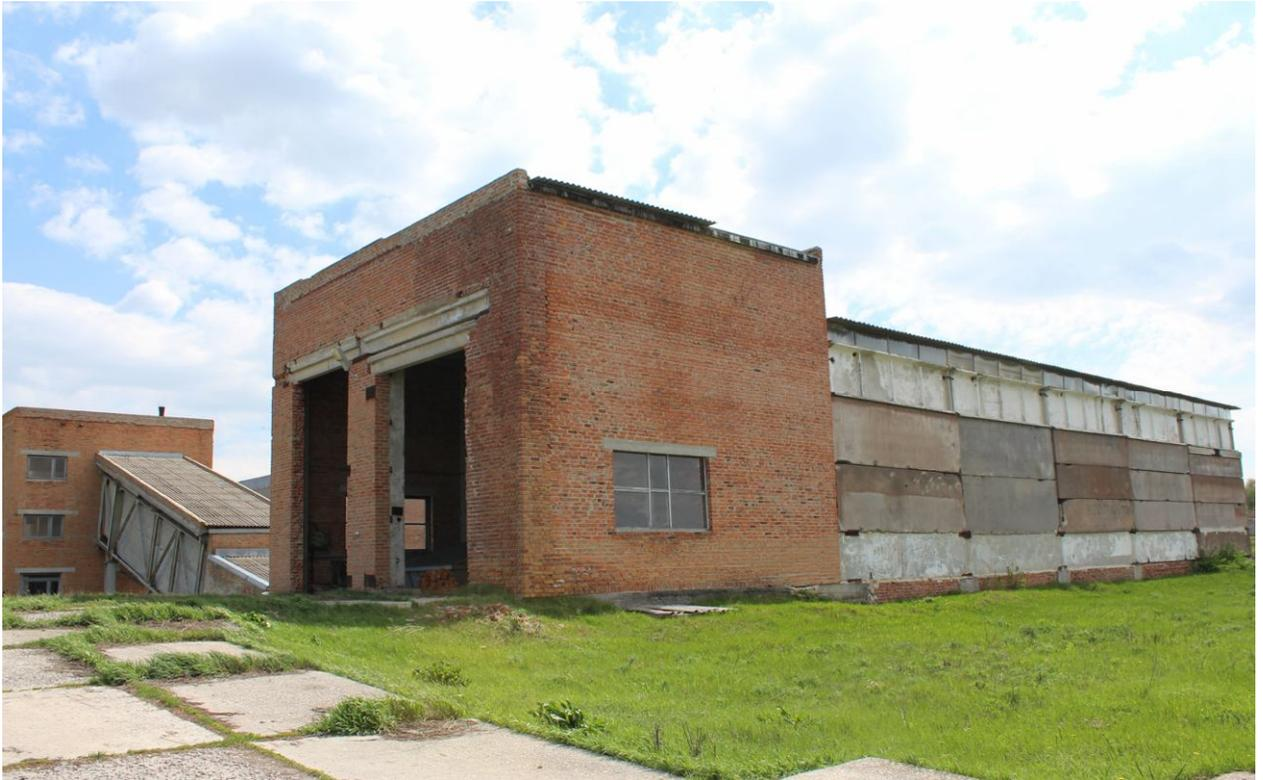
Состоит из двух одноэтажных зданий площадью 360 кв.м (12,00 х 30,00 м) и 108 кв.м (9,00 х 12,00 м). Оба здания каркасные из сборного железобетона.
