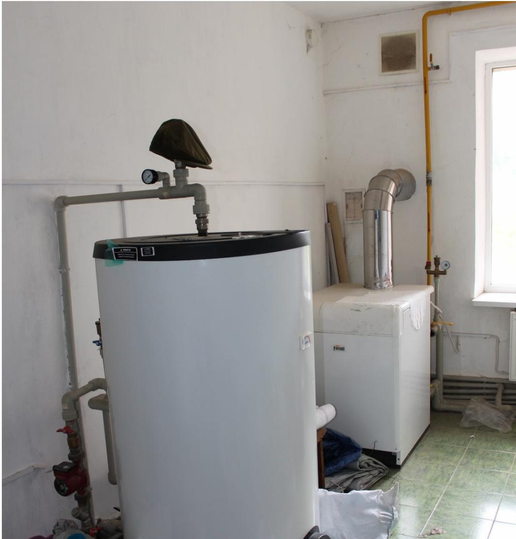
В административном здании построена теплогенераторная. Максимальный расход газа по теплогенераторной составляет 10,4 м<sup>3</sup>/час.
